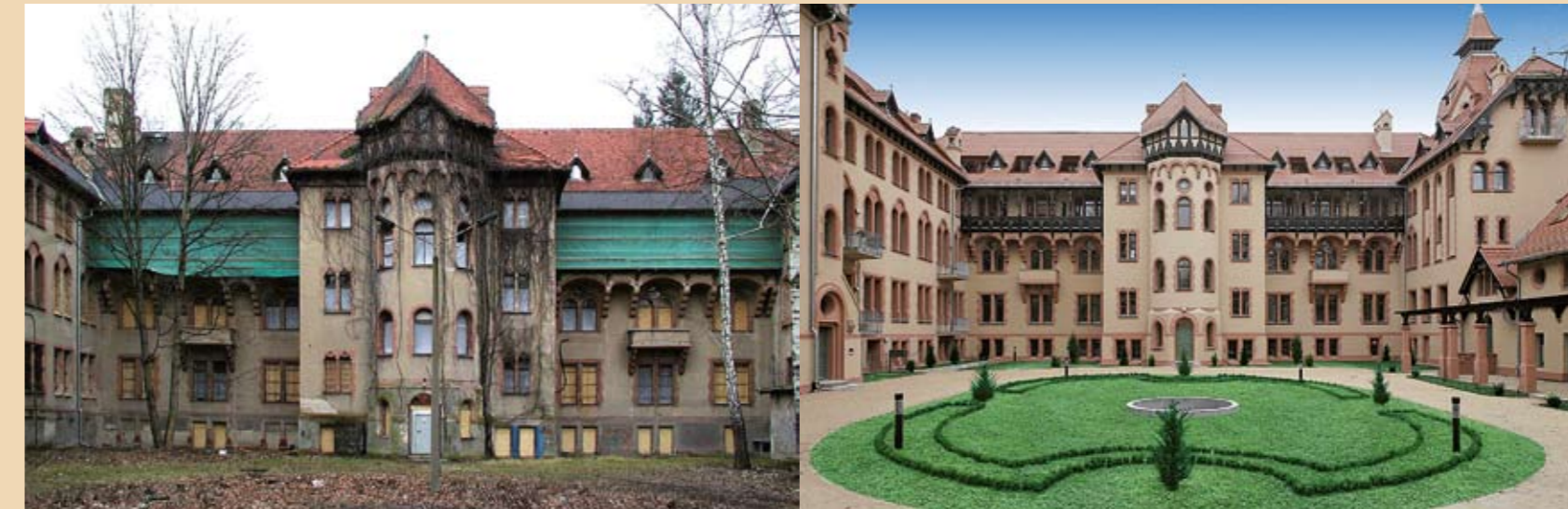
KAISERIN-AUGUSTA-STIFT am Neuen Garten, Potsdam: links vor der Sanierung, rechts bezugsfertig nach Abschluss der Arbeiten
