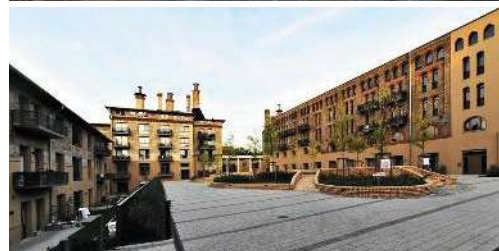
Blick auf die Alte Mälzerei in Berlin – vor (oben) und nach den Restaurierungsarbeiten am Gebäude
